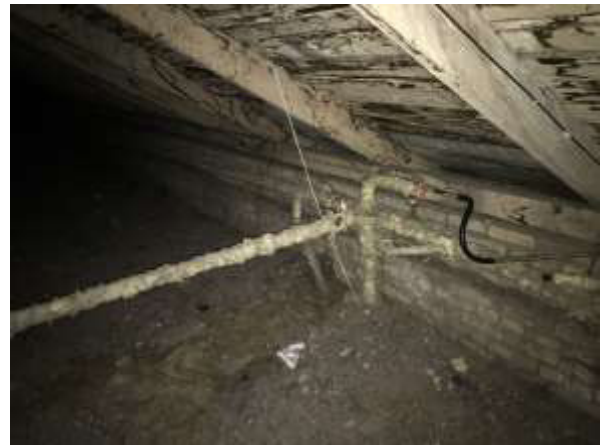
24.att. Cauruļvadi bēniņos ir siltināti ar minerālvati, kuru piesienot tai tiek mainīts blīvums un tās termiskā pretestība samazinās,
