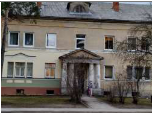
8.att. Lielākā daļa ēkas logu ir nomainīti ar divstiklu pakešu logiem PVC rāmī, atsevišķos dzīvokļos ir arī trīsstiklu logi PVC rāmī, atsevišķi logi nav mainīti.
