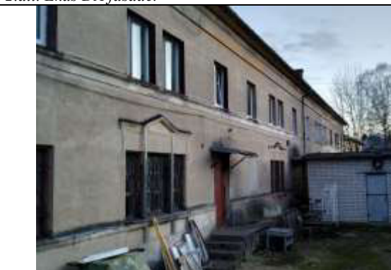
4.att. Ēkas ZR fasāde iekšpagalmā.
