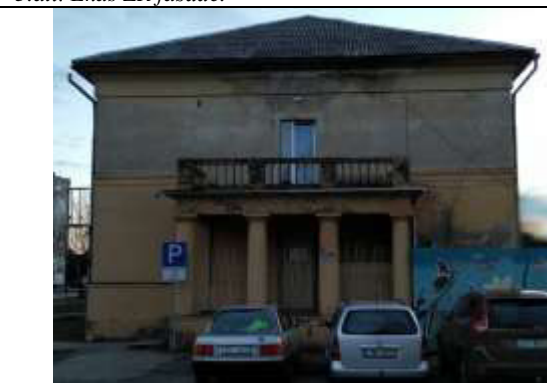
5.att. Ēkas ZA fasāde.
