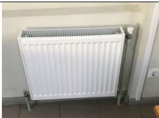
9.att. Ēkā esošie sildķermeņi lielā daļā ir jauni. Doktorātā ir divcauruļu sistēma, bet pārējā ēkā viencuruļu sistēma.
