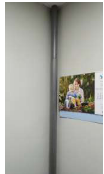
26.att. Doktorātā stāvvadi, kas nāk no iedzīvotājiem "siltināti"..
